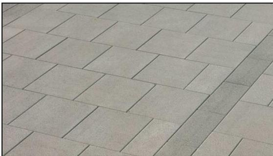
**Figura 2** - Pavimentazione in lastre di cls uguali tra di loro per tipologia e dimensione
