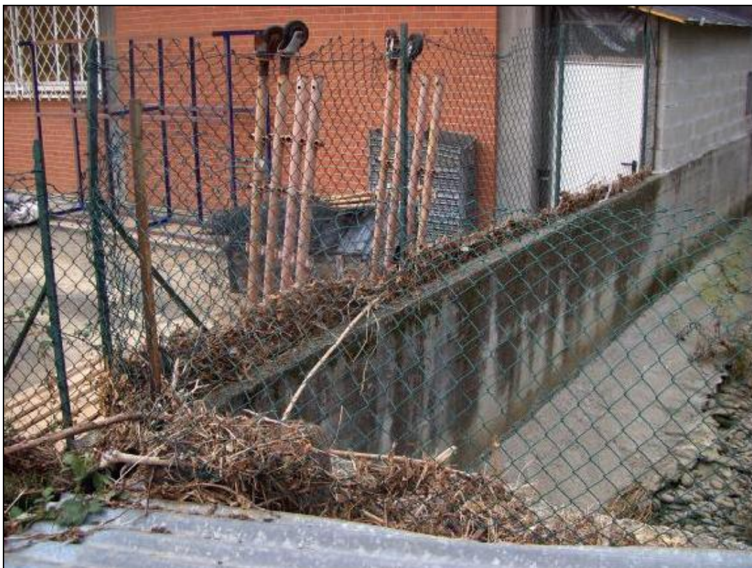
Foto 6 – Tracce del passaggio dell'acqua di tracimazione
