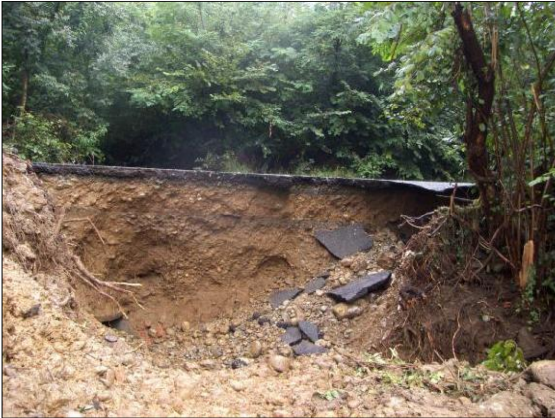
Foto 3-4 – Via San Maurizio: asportazione di parte del corpo stradale a valle della Cascina Fasello. È visibile la sezione di valle dell'attraversamento del fosso irriguo.
