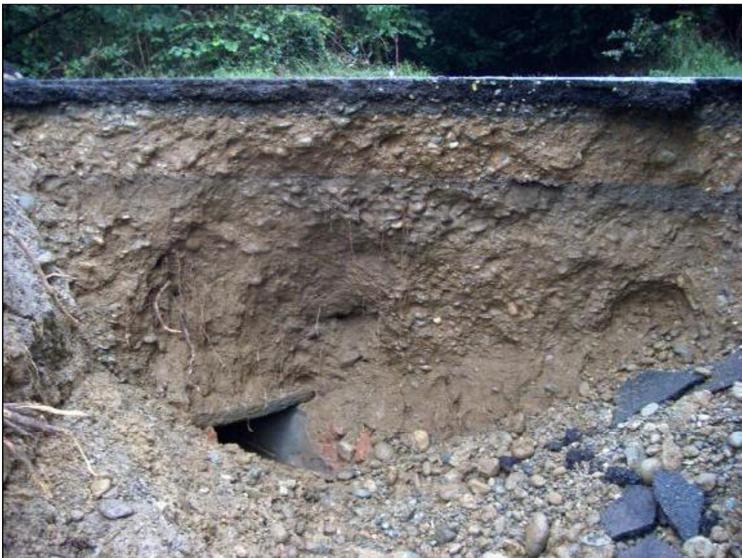
Foto 3-4 – Via San Maurizio: asportazione di parte del corpo stradale a valle della Cascina Fasello. È visibile la sezione di valle dell'attraversamento del fosso irriguo.
